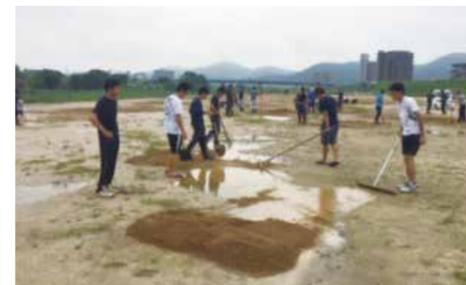
私たちが日頃から利用している「ワイワイ広場」も大きな被害を受けました。みんなで何とかしようと、7月14日には片付け(ユニックも入り倒れた倉庫を建て直し修理、数百メートル先まで流されたフェンスやバックネットの運搬)、8月18日、9月8日(20立米真砂土を入れて手作業で整地)と毎回百名以上の関係者が集結し、グラウンドの復旧に汗を流していただきました。また、業者にもお願いし、内野にはダンプ20杯の真砂土を入れて整地もしました。間にも軽トラックでの整地作業もしました。できることは何でもし、10月7日には宇野学区の運動会、11月3日には子ども会のソフトボール新人戦も開催できました。皆さんの力に感謝・感謝です。
