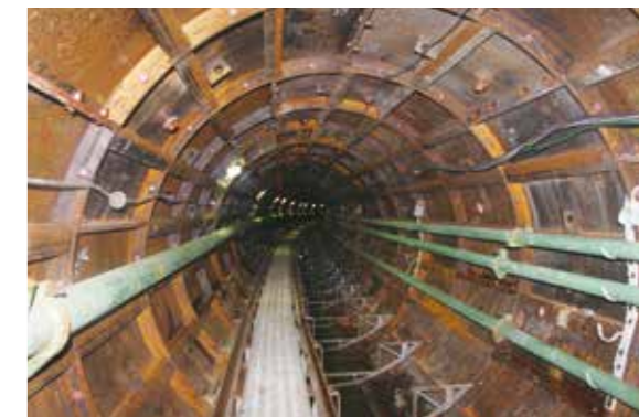
半田山シールドトンネル内部
